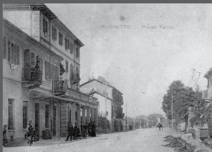
Confronto tra l'immagine odierna e una di inizio Novecento della porzione del fronte occidentale di corso Moncalieri, che ha conservato inalterati i propri caratteri tipizzanti.
