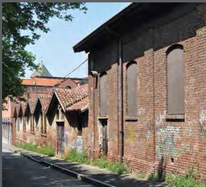
Il fabbricato industriale in via della Brocca, rara testimonianza del borgo.
