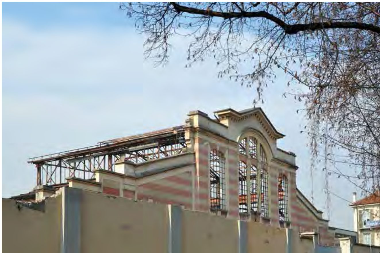
16. Le ex Fonderie Ballada in corso Verona tra le vie Foggia e Perugia: uno scheletro in attesa di una nuova vita.
