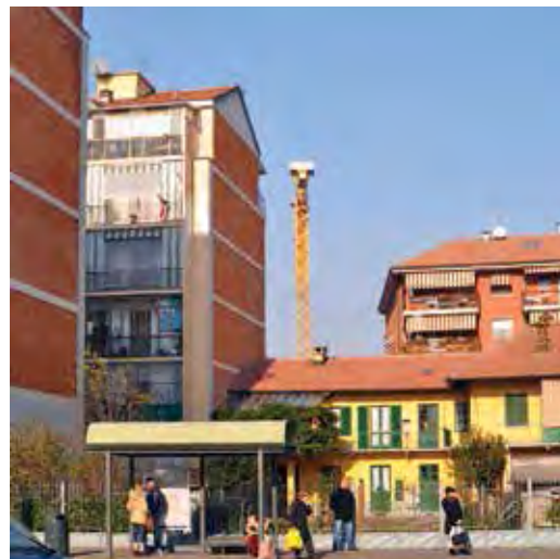
7. Complessi edilizi di ultima generazione visti da borgata Vittoria e da strada San Mauro.
